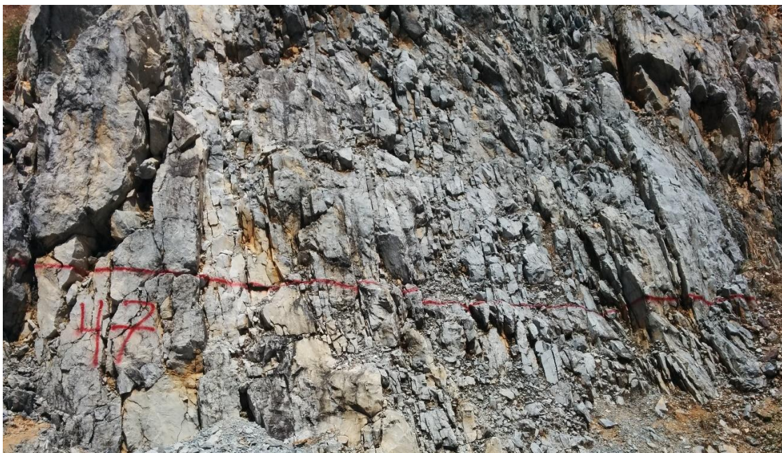
Figura 10 – Face sul do afloramento 03 de mármore dolomítico, indicando o local de coleta de oito metros (linha vermelha) da amostra AM-04, evidenciando intenso fraturamento.
