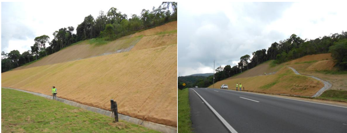
Figura 41: Encosta nas adjacências da área de estudo classificada pelo FS como de alta suscetibilidade à escorregamentos. Área tratada, com retaludamento em bancadas coberto malha de metal grampeada e sobreposta por malha sintética e gramíneas. Nos andares das bancadas foram instaladas canaletas de concreto para escoamento da água. Área tratada, aparentemente estável.
