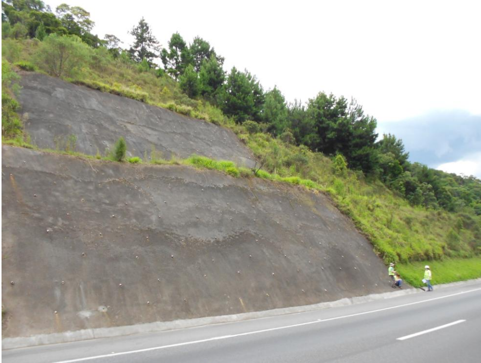
Figura 40: Encosta nas adjacências da área de estudo classificada pelo FS como de muito alta suscetibilidade à escorregamentos. Área tratada, com retaludamento em bancadas coberto por injeção de concreto e com drenos de PVC instalados a cada 1 metro. Área tratada, aparentemente estável.
